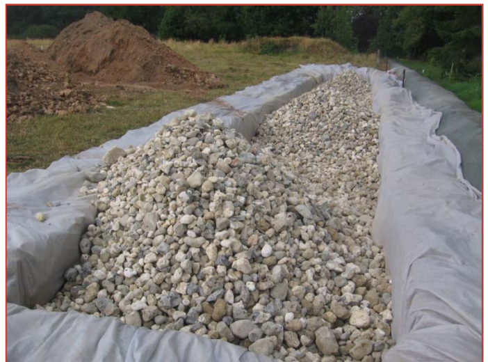
Mise en place du géotextile
