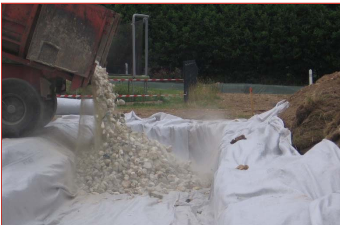
Mise en place de la grave
