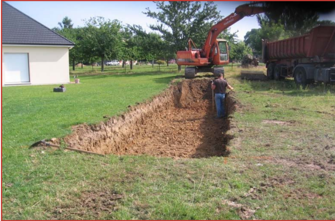
Terrassement du massif drainant
