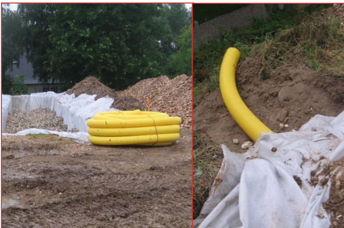
Installation de la canallisation de drainage
