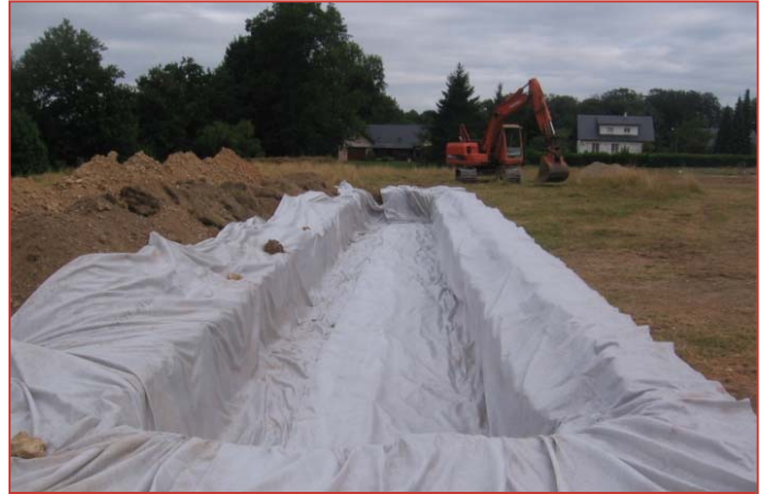
Mise en place du géotextile
