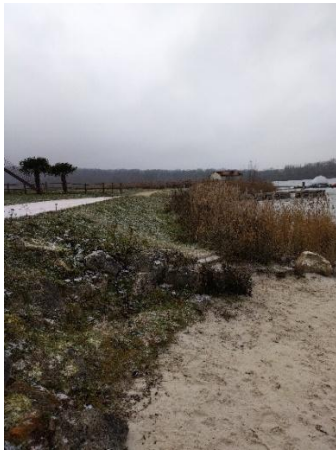
Création rampe PMR plage Nord
