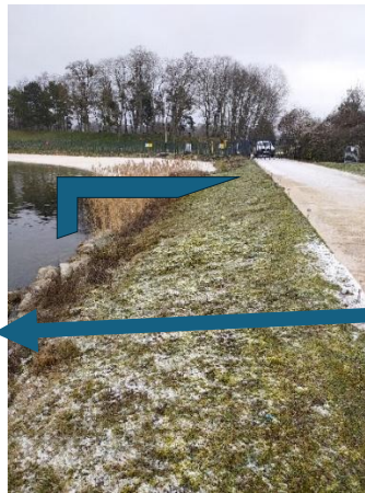
Création rampe PMR, Allée Retour sur 20m Dénivelé à récupérer 1.20m
